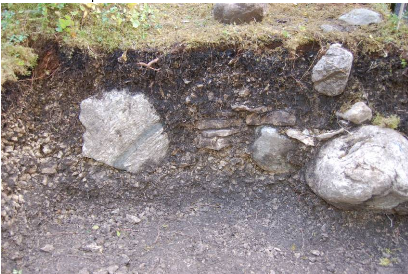
Bild IX. Ö profilen i Ruta 9. Kallmur i V stödmuren.
